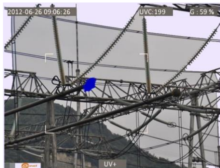
Rys. 5-8. Wyladowania koronowe w warunkach rzeczywistych sieci energetycznych.
